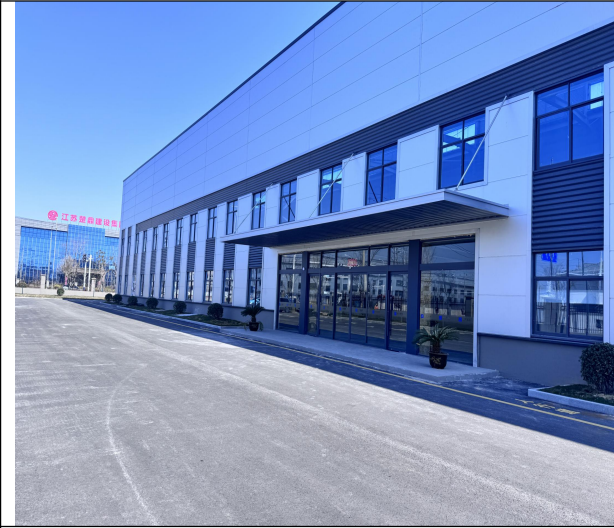
建筑物区（2025 年 4 月）
