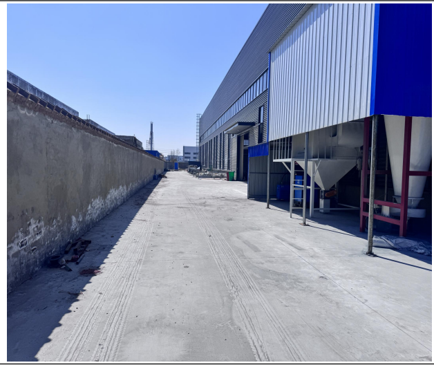
建筑物区（2025 年 4 月）
