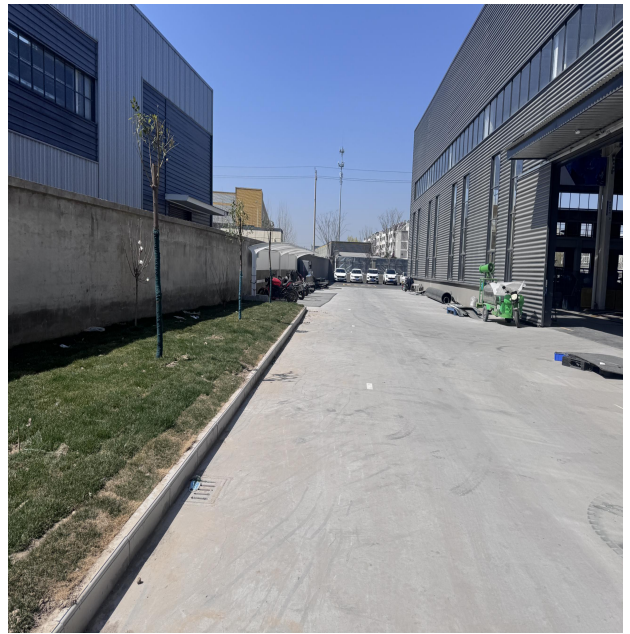
路面硬化 (2025 年 4 月)
