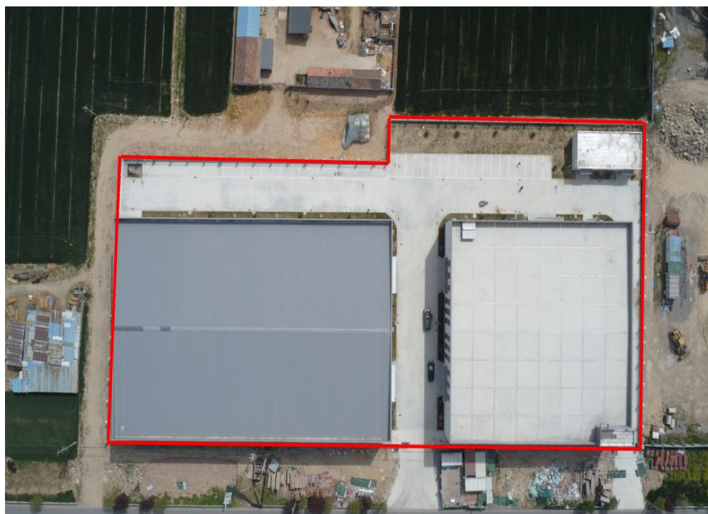
竣工后全景图（2025.4）
